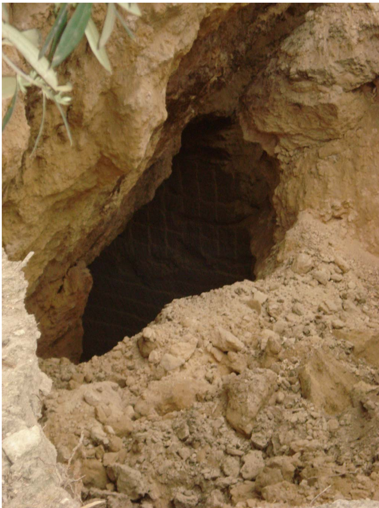
Foto del 4 maggio ore 19.00 particolare cunicolo artificiale con evidenti segni di coltivazione di calcarenitite con volta a -6,00 m circa dal p.c. (direzione cunicolo 25^{\circ} \div 30^{\circ} N)
